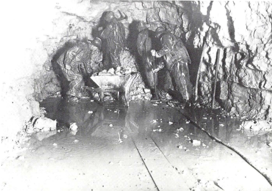
Fig. 46. Sydhavnstunnelen. Servicetunnel under Københavns Havn fra Enghave Brygge til Islands Brygge (se fig. 47). Arbejdere i færd med at hugge sig frem gennem København Kalken. Efteråret 1921. Bemærk kalkens tydelige bænknings. Venligst udlånt af Alfred Rosenkrantz. Fig. 46: The Sydhavnstunnel. Service tunnel in København Limestone under the south harbour of Copenhagen (location shown at fig. 47). Notice the jointing of the limestone. Courtesy of Alfred Rosenkrantz.
