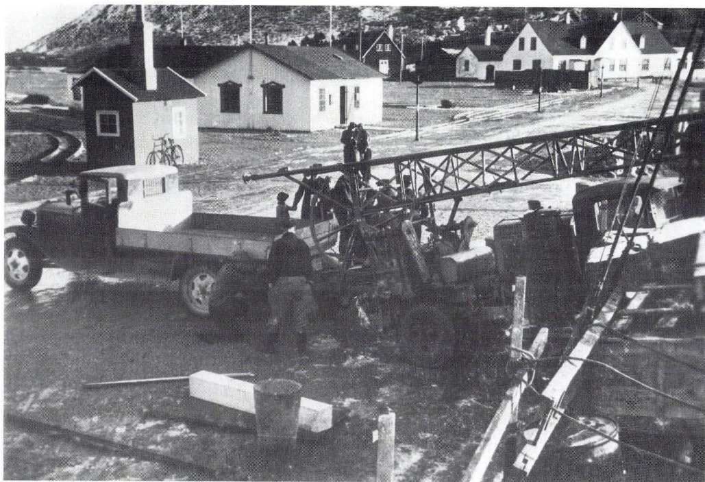
Fig. 4. Unloading of the bore rig in Anholt Harbour. Note the gas generator behind the drivers cabin on the lorry to the right. Boretårnets ilandsætning i Anholt Havn fra skibet. Bemærk lastbilen med generatorgas-anlæg.
